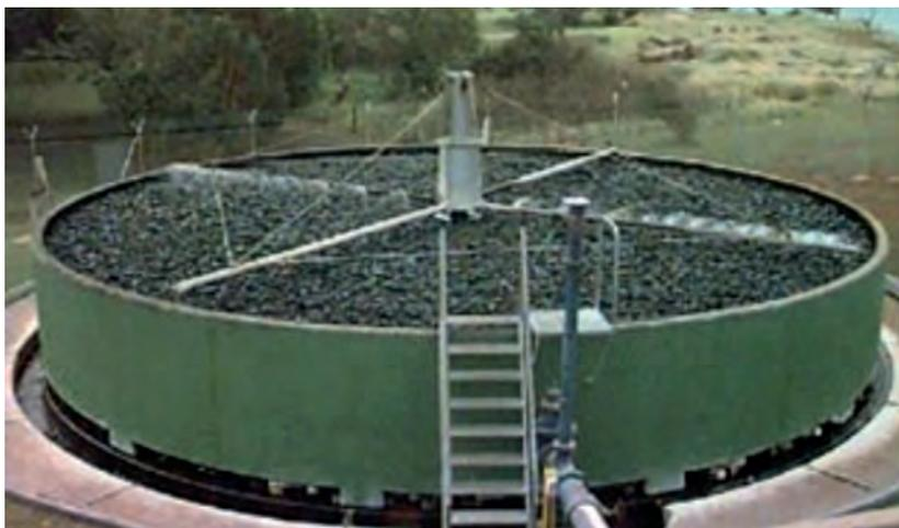
Este sistema presenta ventajas como la estabilidad ante variaciones de la carga y concentración afluente, bajos costos de operación y mantenimiento comparados con otros procesos del tipo convencional, producen un lodo estable concentrado (en general bien floculado y fácil de decantar) y son de fácil puesta en marcha luego de una detención.
