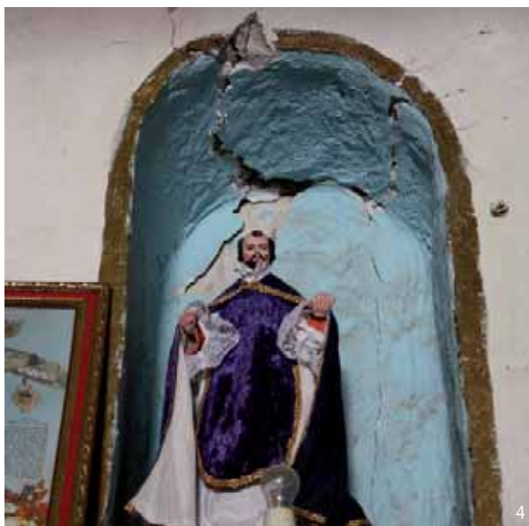
1. Colapso de contrafuerte en muro Evangelio. 2. Grieta pasante vertical en adelantamiento de muro de la Epístola en muro fachada. 3. Erosión e intervenciones deficientes en techumbre. 4. Grietas, desprendimiento e intervención deficiente en retablo de Altar Mayor.
