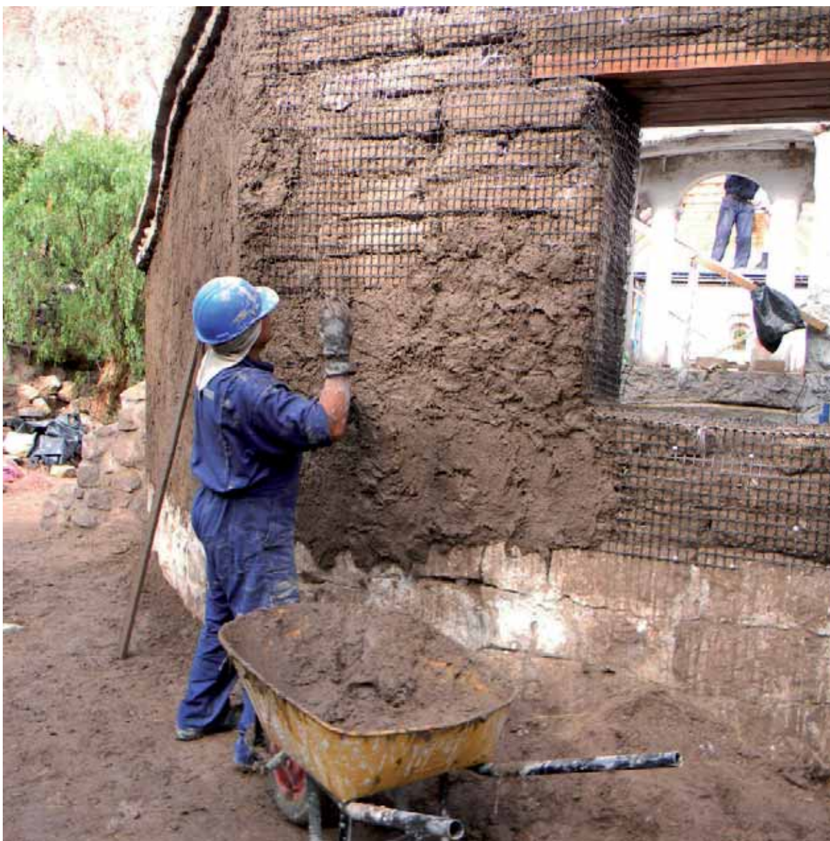
Trabajos de consolidación de muros de adobe con sistema de confinamiento con geomalla como medida de refuerzo estructural.
