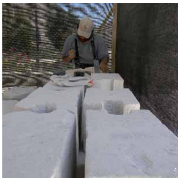
Trabajos de restauración. 1. Fabricación de adobes. 2. Liberación de estuco de cal en muro fachada. 3. Recolección de piedras en cantera cercana al pueblo. 4. Maestro canteando piedra en Escuela Taller.
