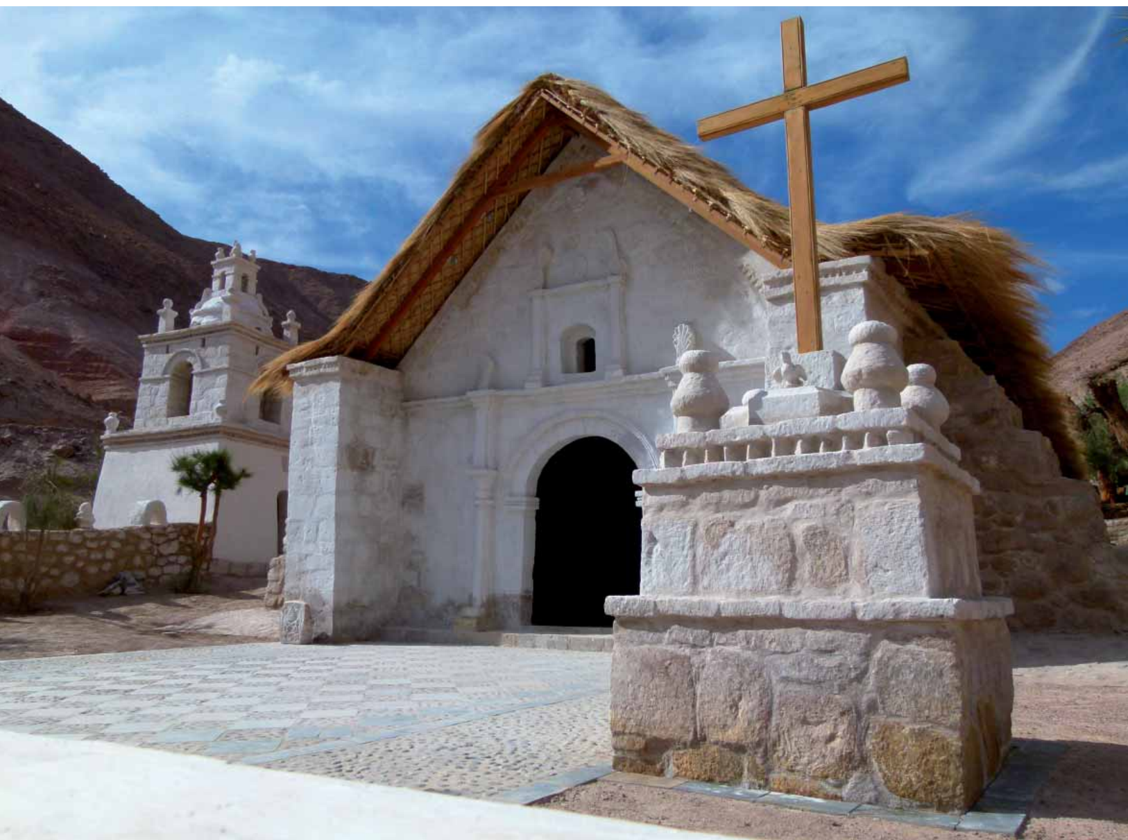
Iglesia de San Pedro de Guañacagua restaurada.
