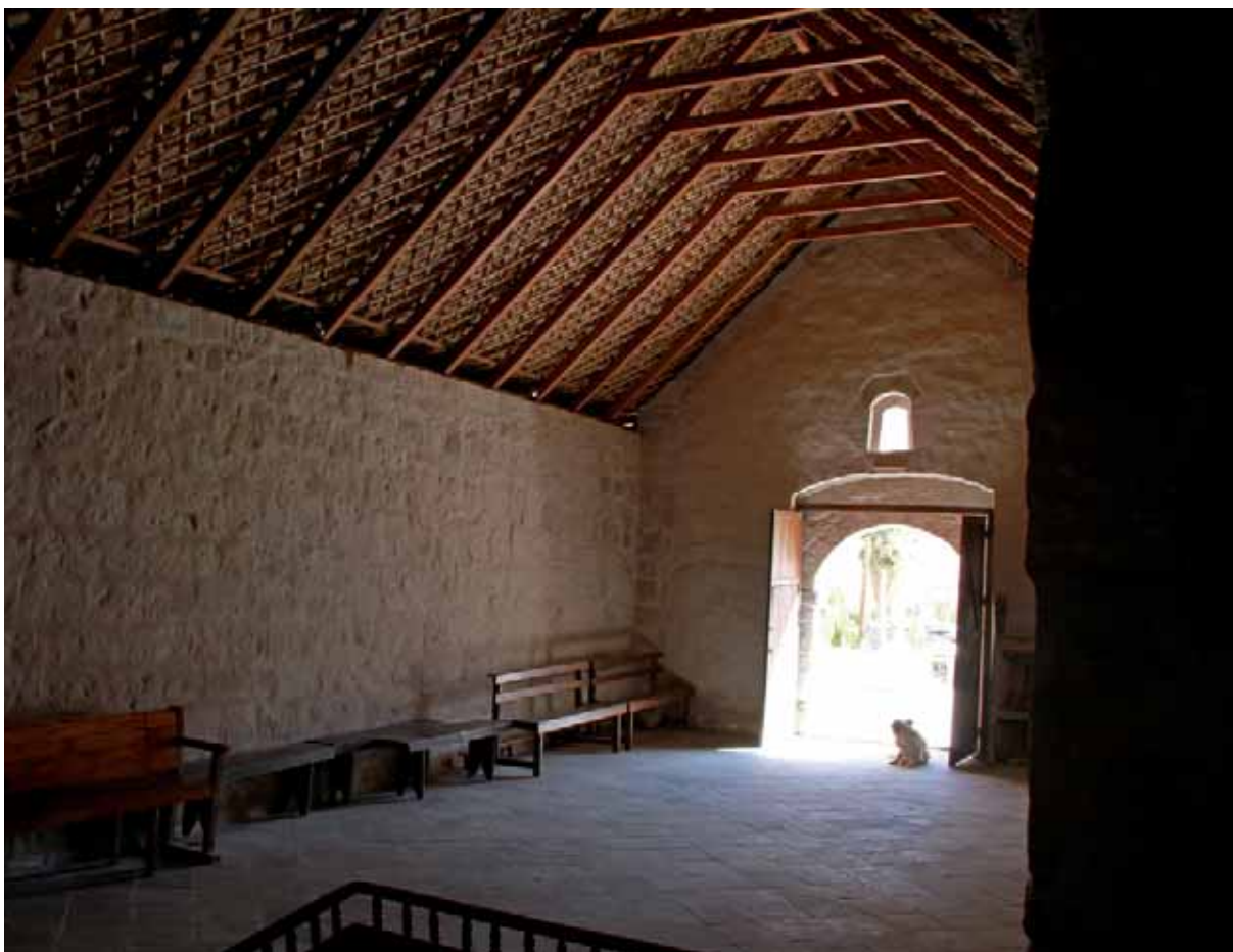
Interior del templo luego de los trabajos de consolidación de los muros.
