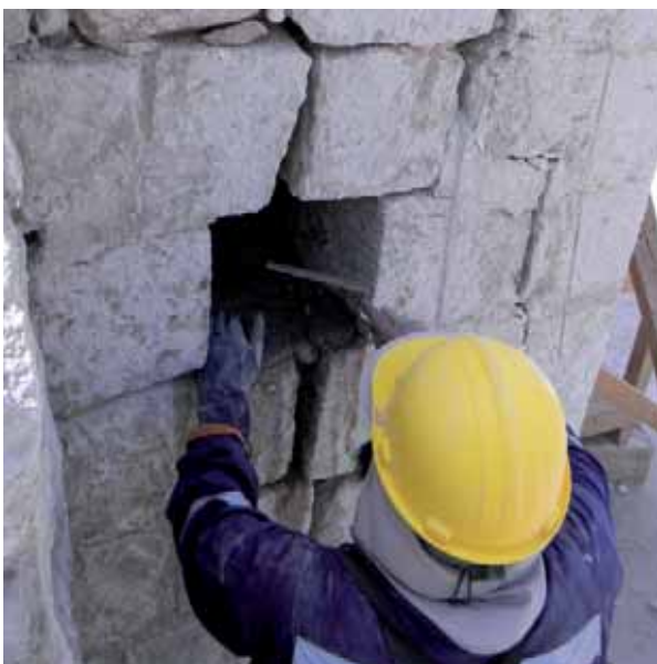
Trabajos de consolidación de muros de piedra.
