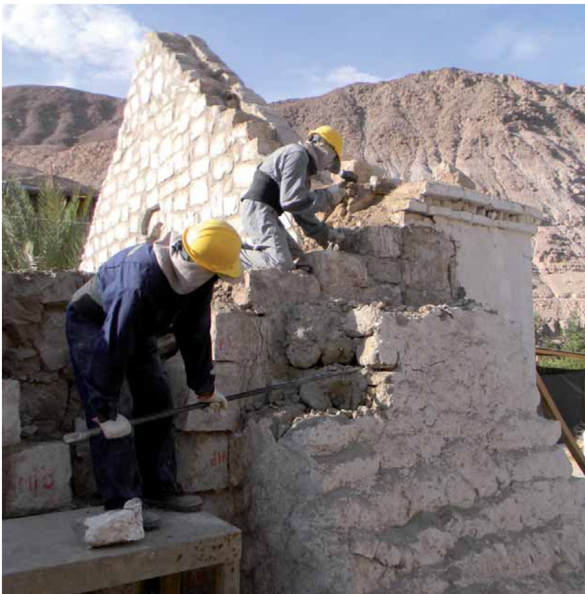
Trabajos de mejoramiento en conexión de contrafuertes y muros de piedra.
