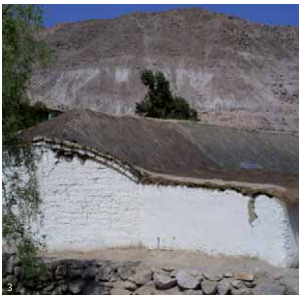
1. Colapso de contrafuerte en muro Evangelio. 2. Grieta pasante vertical en adelantamiento de muro de la Epístola en muro fachada. 3. Erosión e intervenciones deficientes en techumbre. 4. Grietas, desprendimiento e intervención deficiente en retablo de Altar Mayor.
