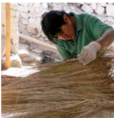
Trabajos de restitución de la techumbre. Destaca la recolección y tejido de paja brava.
