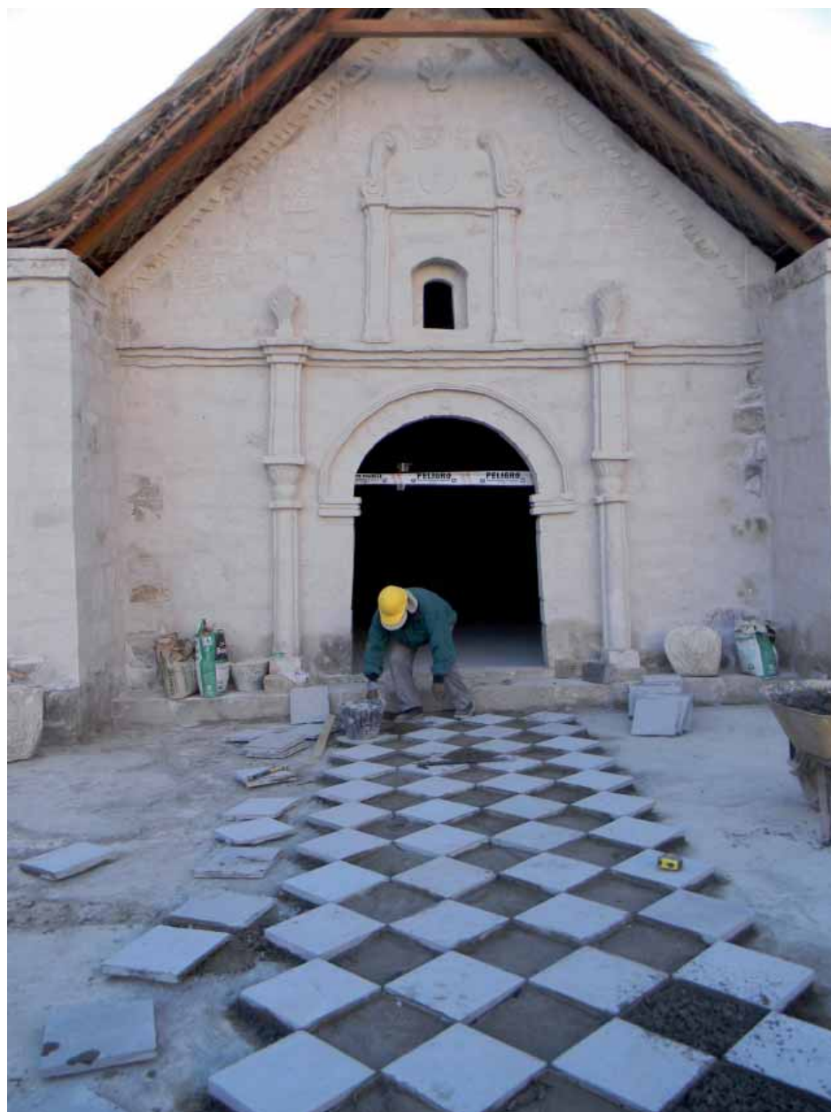
Trabajos en atrio del templo.
