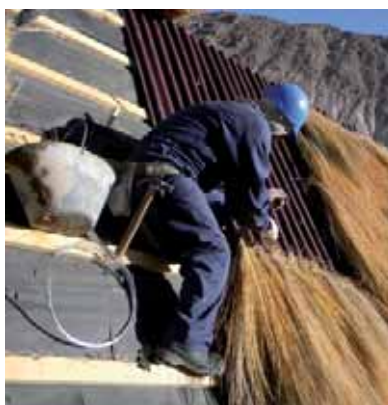
Trabajos de restitución de la techumbre. Destaca la recolección y tejido de paja brava.
